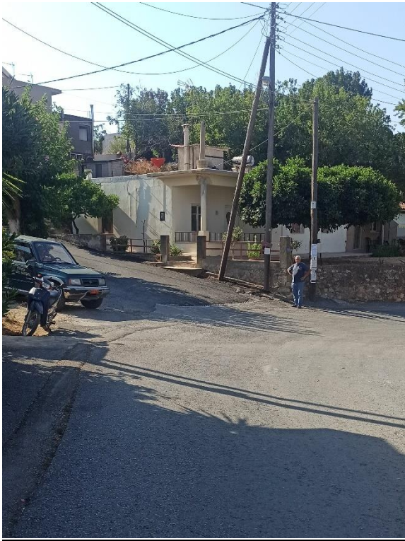
Εικόνα 3. Υφιστάμενη συμβολή χωρίς σήμανση stop.
